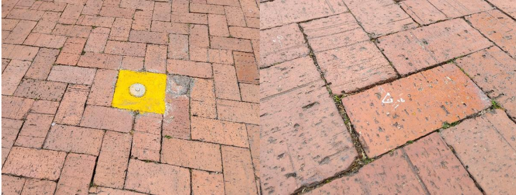
Figura 1. Puntos de armado. Fuente: Propia.
