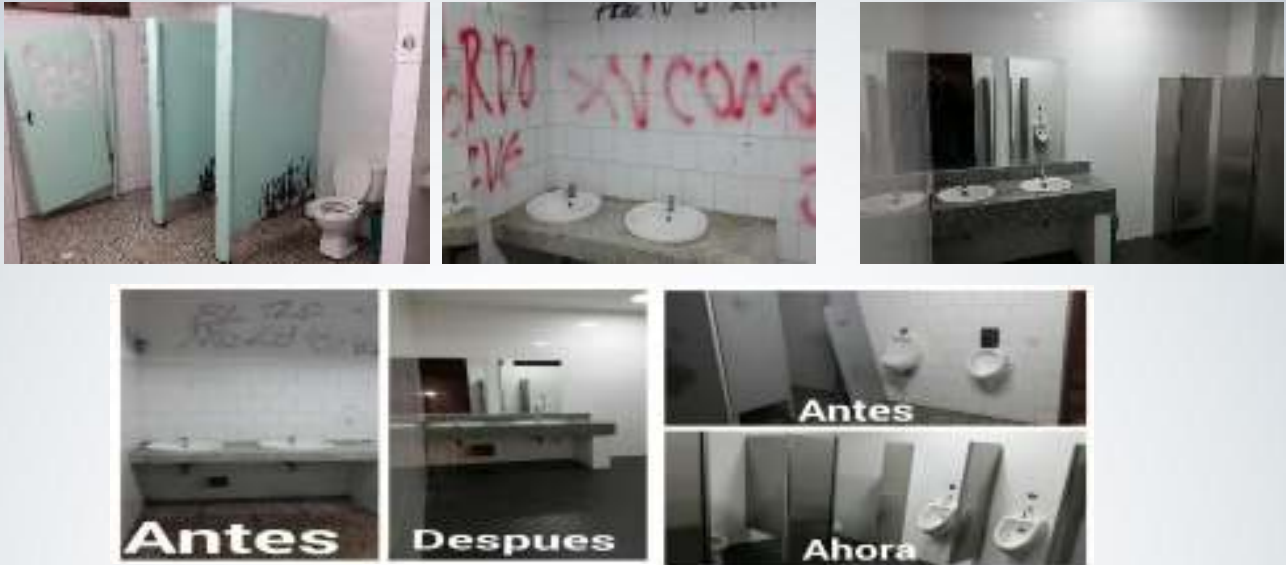
Figura 1. Adecuación de baños y mejoramiento de acabado arquitectónicos
