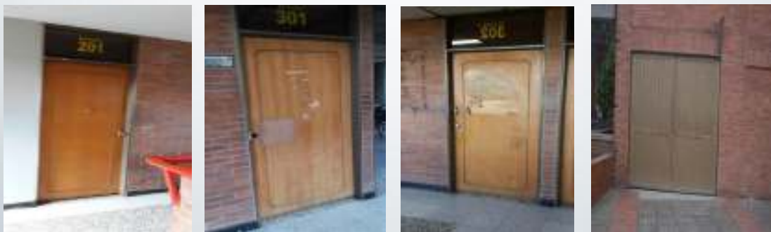
ANTES. Figura 5. Mejoramiento y adecuación a puertas
